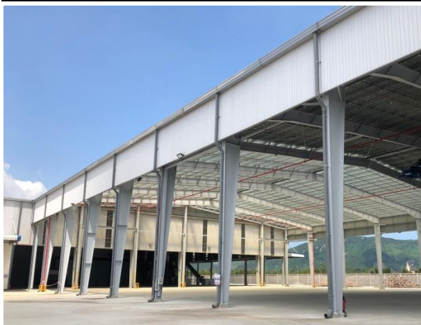
Hình 3.2. Ống PVC thu nước mái
