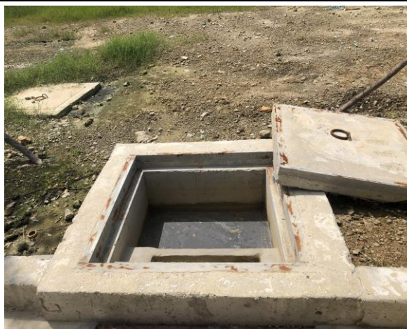
Hình 3.3. Mương bê tông và hố ga
