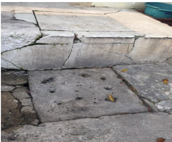
Hình 3.2: Hố gas lắng nước mưa
