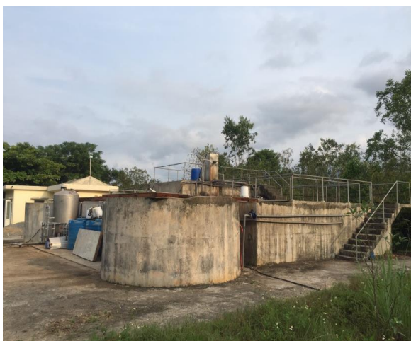
Hình 3.7: Khu vực xử lý nước thải của nhà máy
